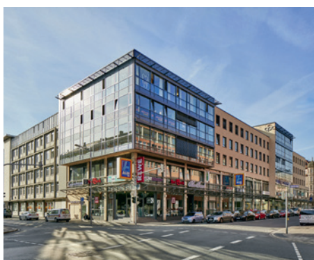
City Park Center, Nürnberg, Deutschland, Büro- und Geschäftsgebäude
